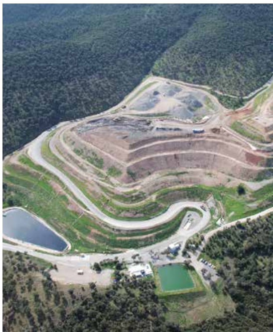
Centre de Stockage de Déchets Non Dangereux de Pierrefeu-du-Var.
