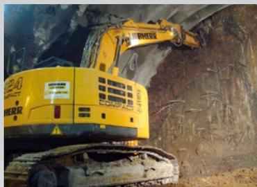
① Une première étape de **préparation** consiste en la mise en place de mesures de pré-soutènement telles que des voûtes parapluie<sup>5</sup> ou du jet-grouting<sup>6</sup>. Cette étape a notamment permis de **sécuriser le front** avant le passage des engins d'excavation et de contrôler les phénomènes de tassement.
