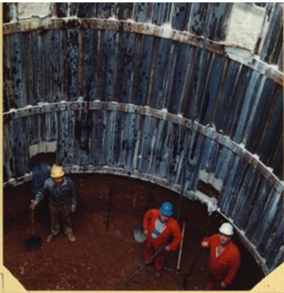
Avant le début des travaux, des puits et des galeries d'exploration ont été creusés sur la totalité du tracé du tunnel. Ces galeries très étroites et basses permettent de contrôler la géologie du sous-sol.
