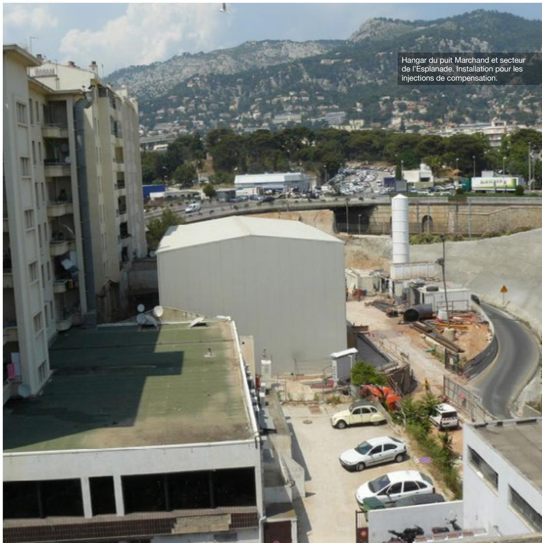
Hangar du puit Marchand et secteur de l'Esplanade. Installation pour les injections de compensation.
