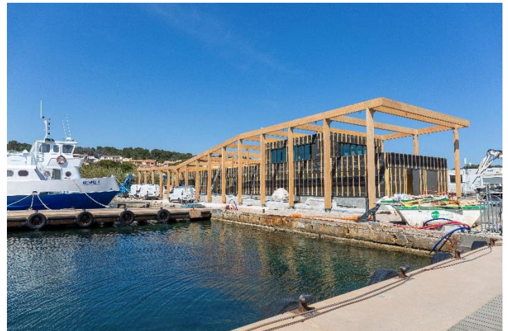
Image du chantier avril 2021 – © Olivier pastor TPM
