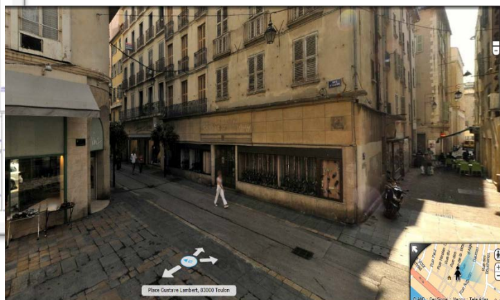
Le site rue d'Alger avant les travaux
